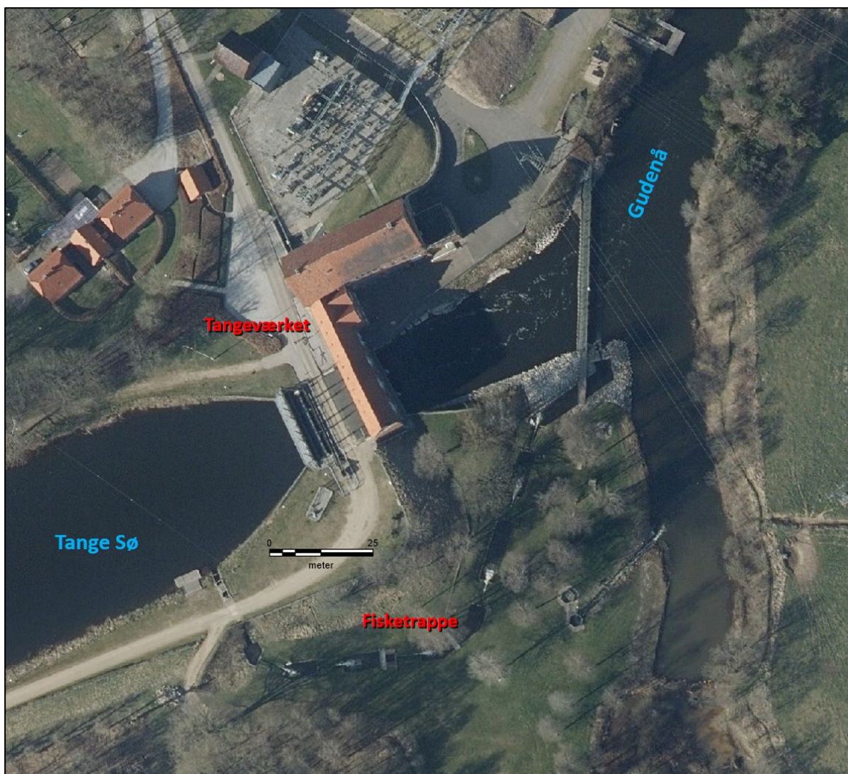
Figur 4. Luftfoto af Tangeværket, foråret 2020, med den eksisterende fisketrappe syd for værket.
