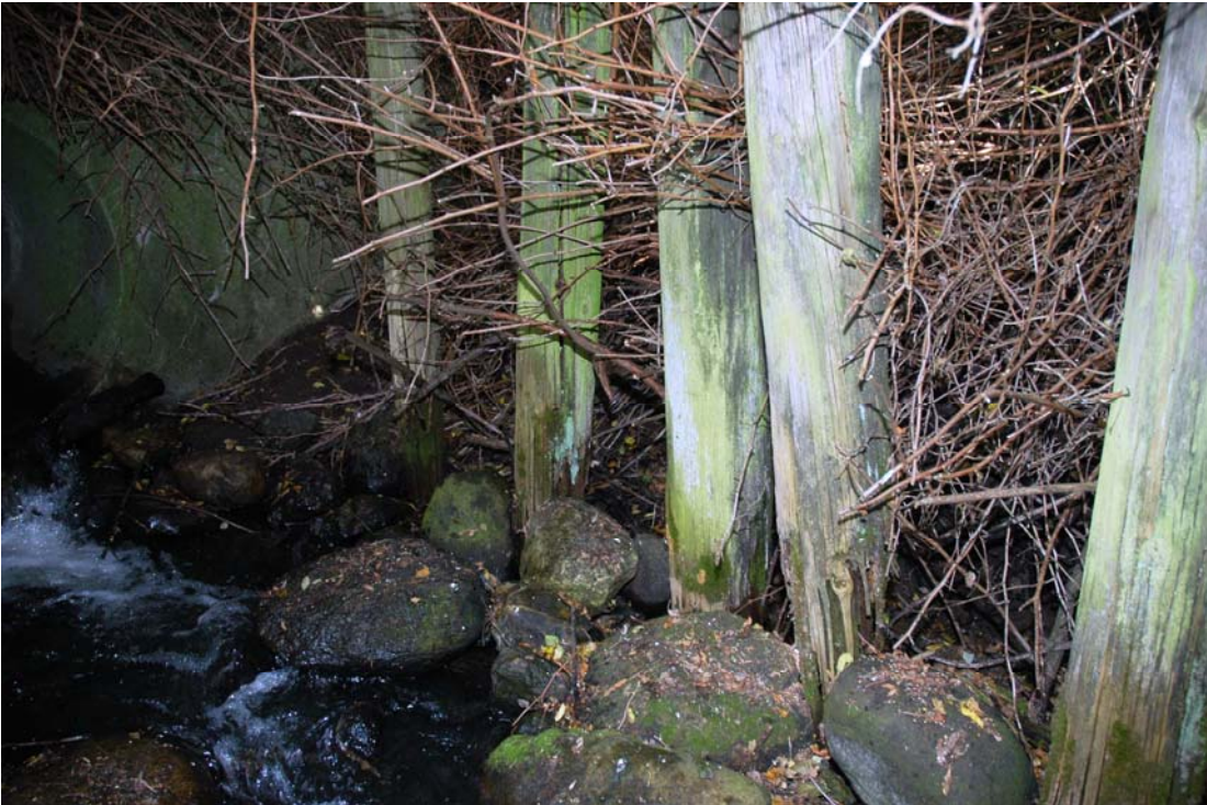
Billede 2: Brinkerne sikres mod erosion med 200-400 mm store sten.
