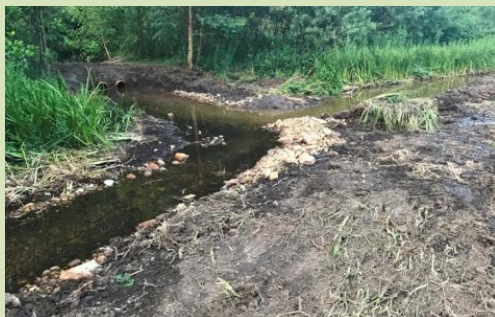
Til venstre på billedet Garverbækkens nye løb. Til øverst til højre det videre forløb som støder sammen med Bøstrup Bæk. Et reduceret indløbet til den gamle mølledam, ses øverst midt i billedet.
