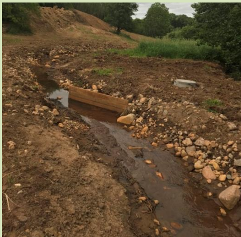
Dette billede viser starten på omløbsstryget til søen nedstrøms Bøstrup Møllegård. I midten af billedet ses vandindtaget til søen.
