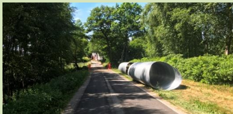
Det nye rør under vejen.
